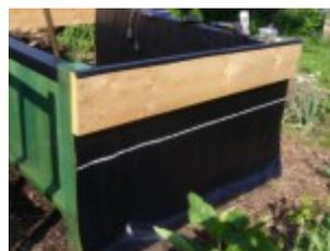
Die Seitenwände werden auf ebenem Boden mit der Wasserwaage ausgerichtet und mit Stirnwänden und Teichfolie zusammen verschraubt.
